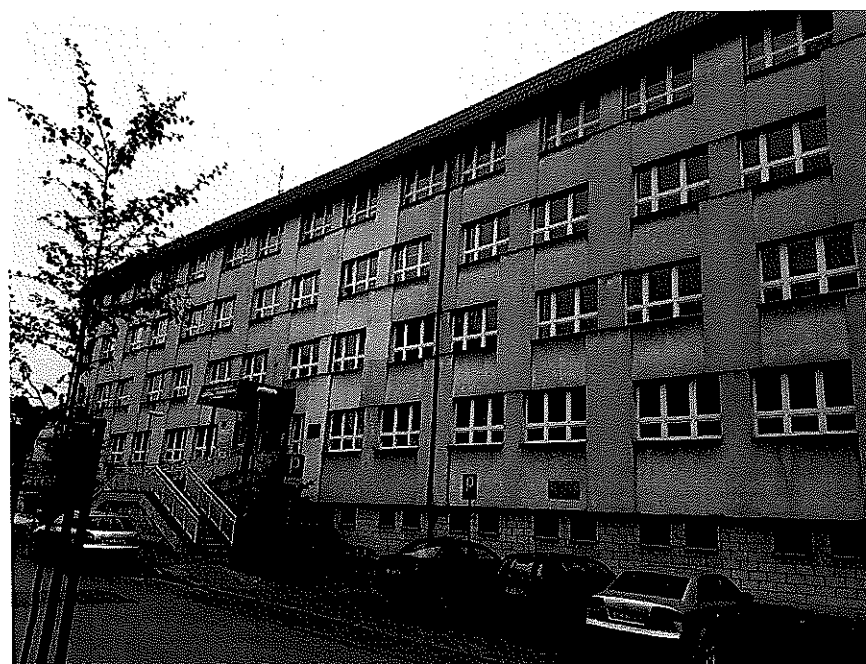
Elewacja budynku A
