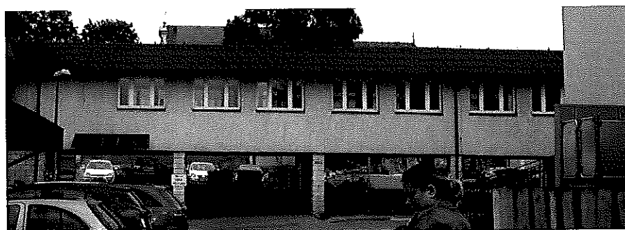
Elewacja budynku E
