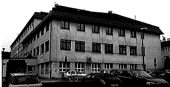
Elewacja budynku B
